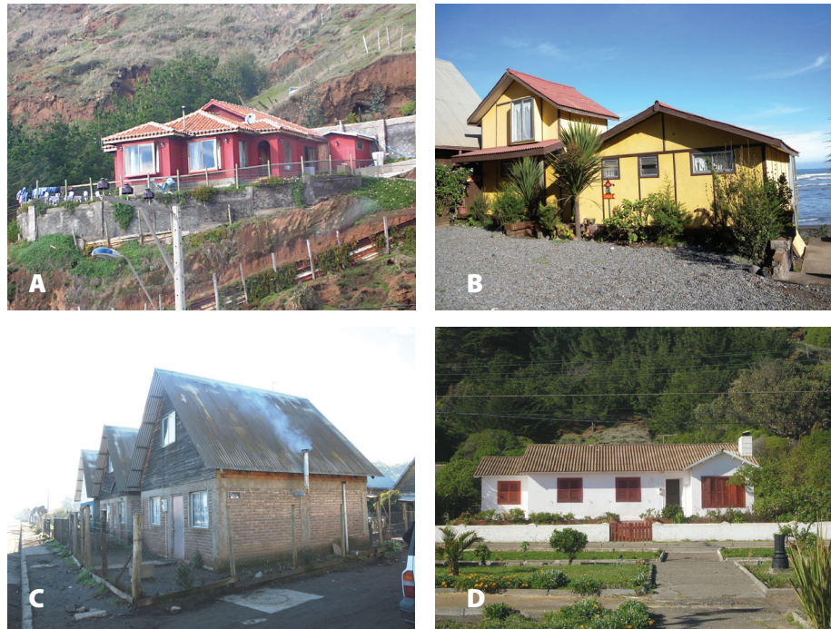
Figura 4. Daños en borde costero (A) Vivienda en Duao, (B) Cabañas en La Pesca, (C) Grupo de viviendas en Putu, (D) Vivienda en Iloca.
