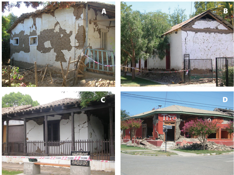
Figura 2. Daños observados en viviendas de adobe. a) Desprendimiento de estuco (G2), b) Grietas verticales en encuentro de muros (G2), c) Grietas diagonales en muro (G3), d) Colapso de más de un muro (G5).
