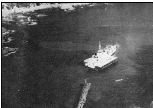
Foto 11: Muelle de acceso parcialmente destruido en caleta Mansa.
