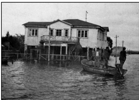
Foto 33: Casa de Queilén a la cual se le ha desarmado el primer piso por inundarse cada vez que sube la marea.
