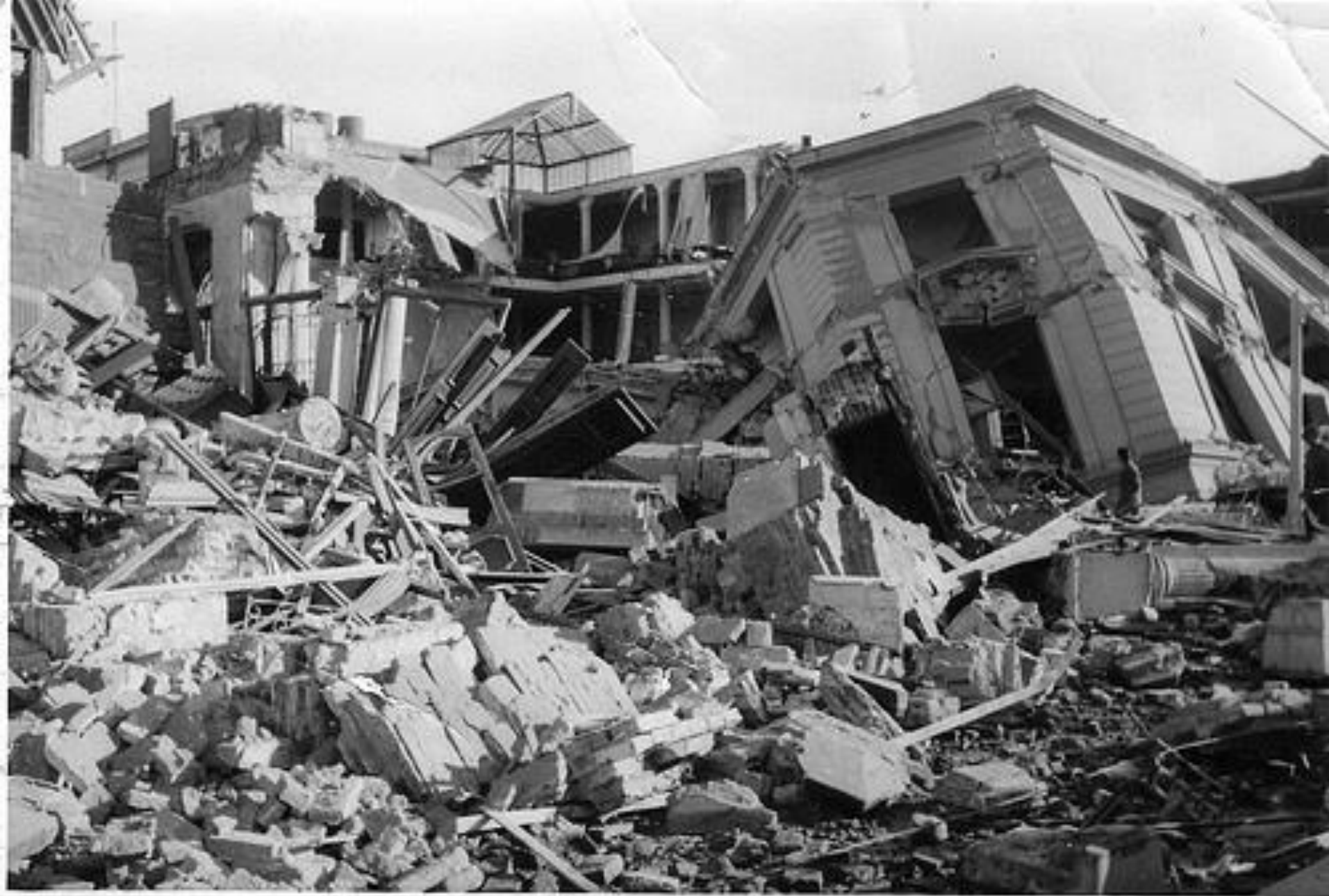
Terremoto de Valdivia, 1960
