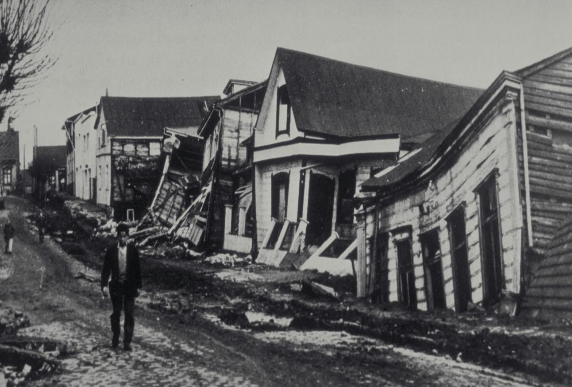
Terremoto de Valdivia, 1960
