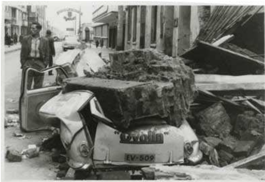
Auto destruido por el derrumbe de una casa provocado por el Terremoto Valdivia el 22 de mayo de 1960. Colección Archivo Fotográfico. Museo Histórico Nacional
