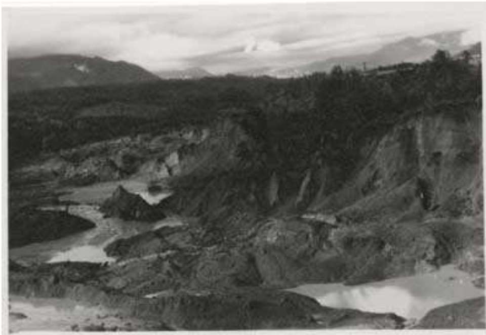
El Terremoto de Valdivia, produjo la obstrucción del desagüe del Lago Riñigüe. Colección Archivo Fotográfico. Museo Histórico Nacional.
