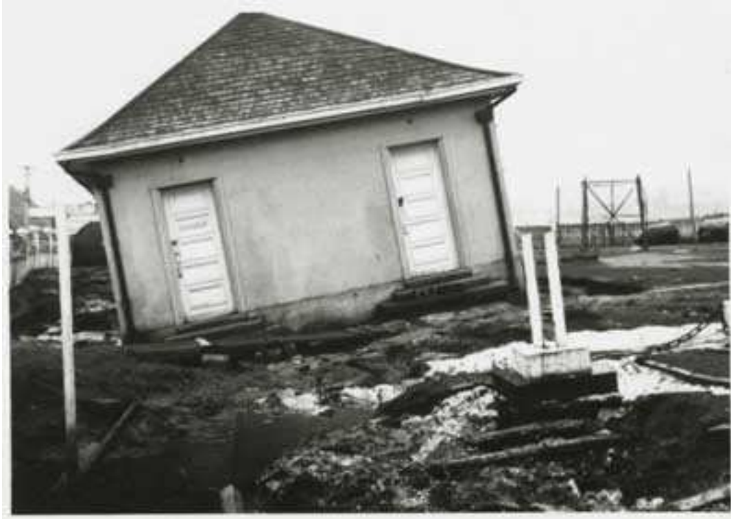
Casa removida de su base, por hundimiento de terreno, producto del terremoto 9.5° Richter ocurrido en Valdivia el 22 de mayo de 1960. Colección Archivo Fotográfico. Museo Histórico Nacional
